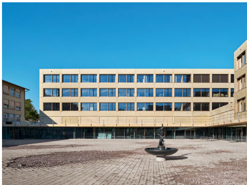
Schulhaus Sandgruben, Altbau (links) und Neubau vom Pausenplatz aus. Der Altbau wird bis Sommer 2017 von Stücheli Architekten instandgesetzt.
