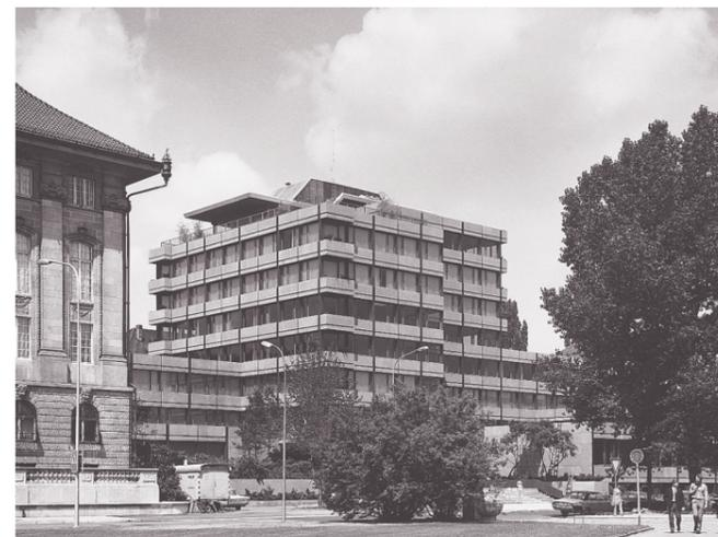
Für den Ende der 1960er-Jahre erstellten Erweiterungsbau der Schweizerischen Rückversicherung war nur das Beste gut genug. Es durften keine künstlichen Materialien verwendet werden, der Bau sollte vollklimatisiert sein und von grösster Flexibilität. Mit dem «Neubau» sollte der neubarocke «Altbau» (1913, Alexander von Senger und Emil Faesch) nach der Erweiterung um das «Clubhaus» (1957, Hans Hofmann) um einen «gediegenen Verwaltungsbau» ergänzt werden.
