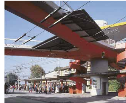
Personenüberführung Bucheggplatz, Zürich
